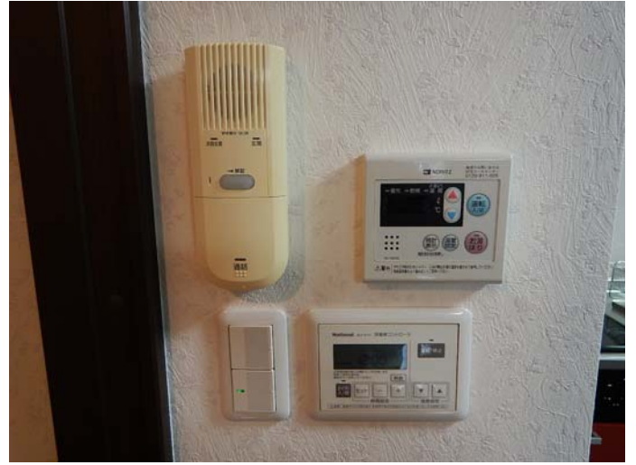
14インターホン・給湯機・床暖房
